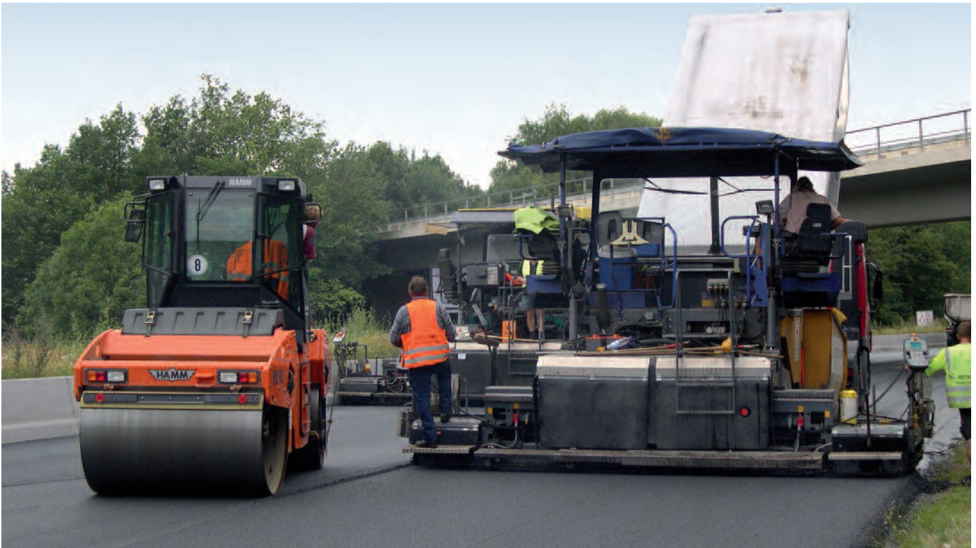
Bild 3 | Instandsetzung der Bundesautobahn A40 zwischen Bochum und Essen im Juli 2007
