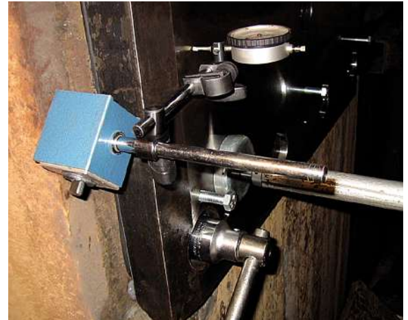
Bild 3: Mit Hilfe von Justierschrauben werden die Schleißplatten eingemessen und mit den Befestigungsschrauben fixiert. Ein Zweikomponenten-Material wird anschließend in die Hohlräume zwischen Walzgerüst und Verschleißplatte gespritzt.
